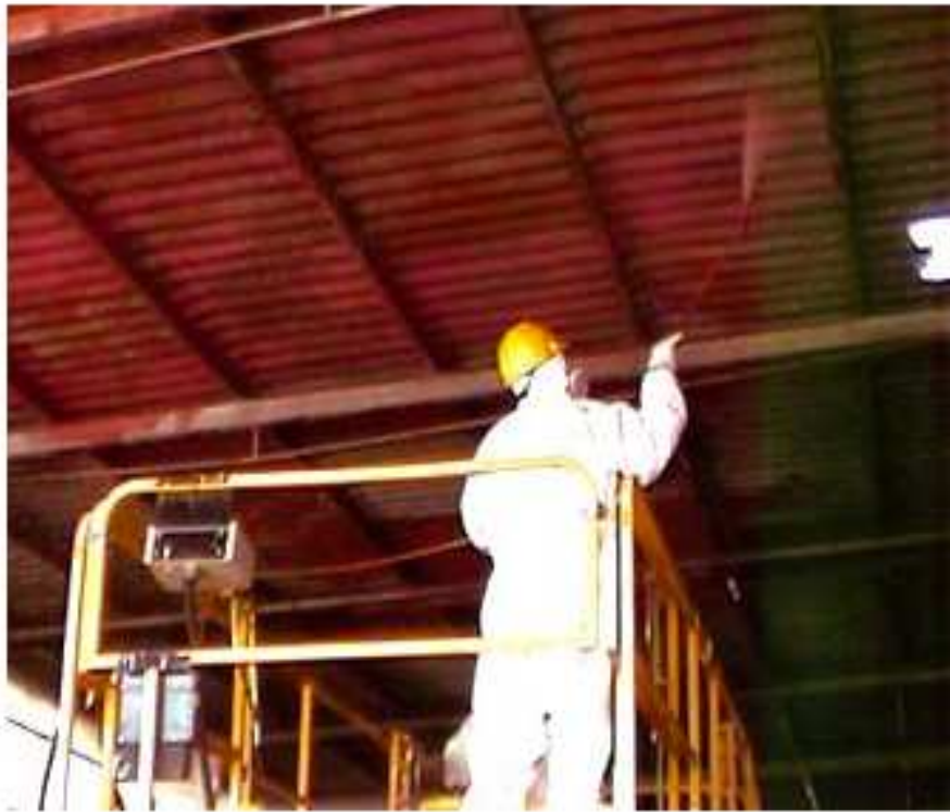
Incapsulamento manufatti in cemento amianto a matrice compatta ausiliario
